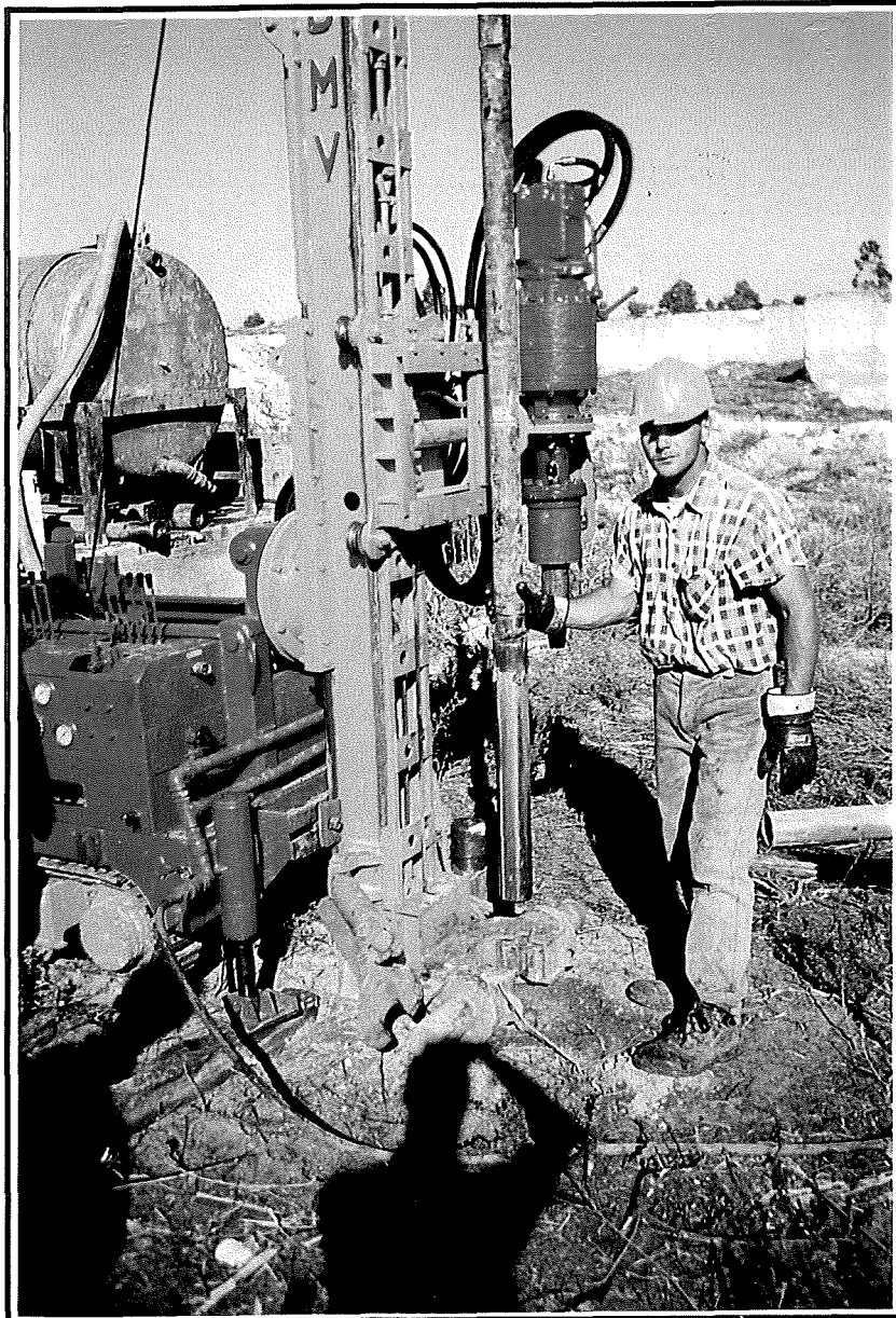
FOTO 3 - Preparazione della fustella di campionamento.
